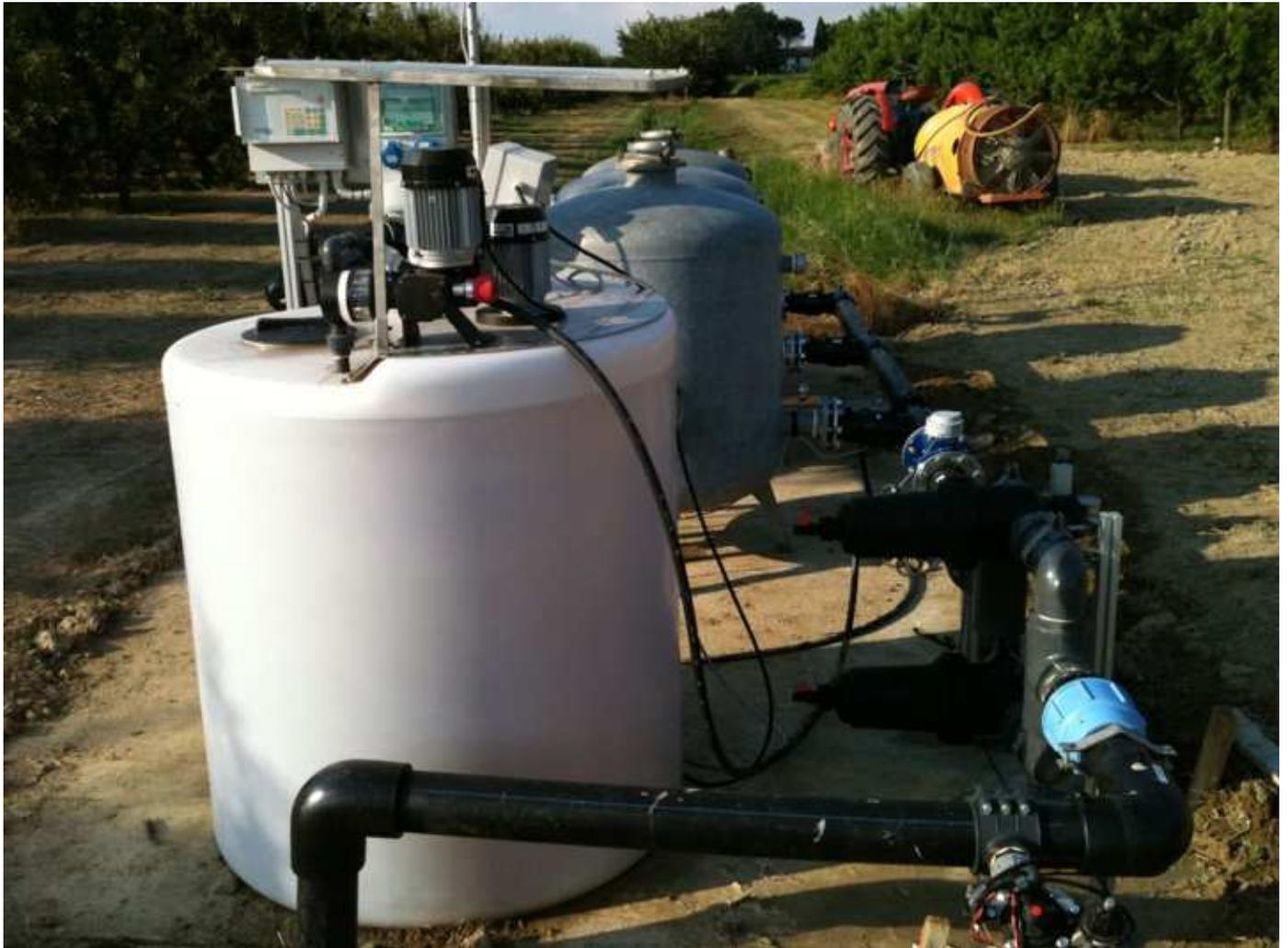
**Quadro elettrico con centralina Agronic 4000 cablata per il controllo di una pompa elettropompa
