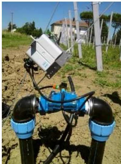
**Stacco valvole settore, con idrovalvole in ghisa elettriche sol.9V e pilota riduzione pressione**
