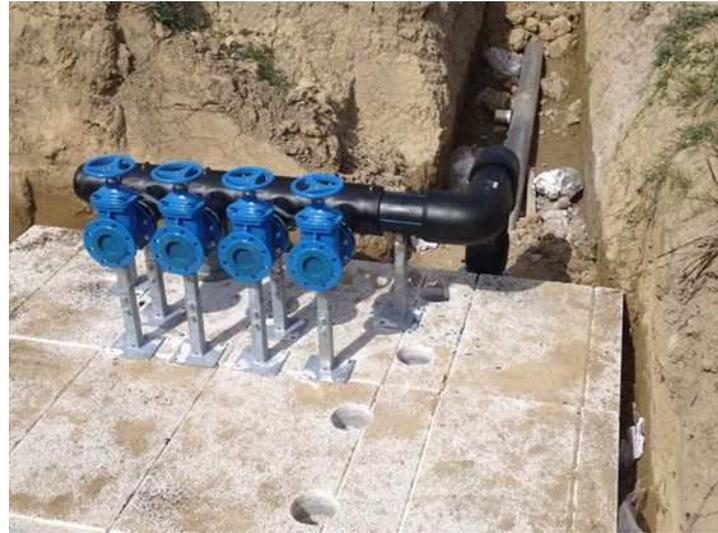
Filtro di sicurezza con stacco idrovalvole con pilota riduzione pressione
