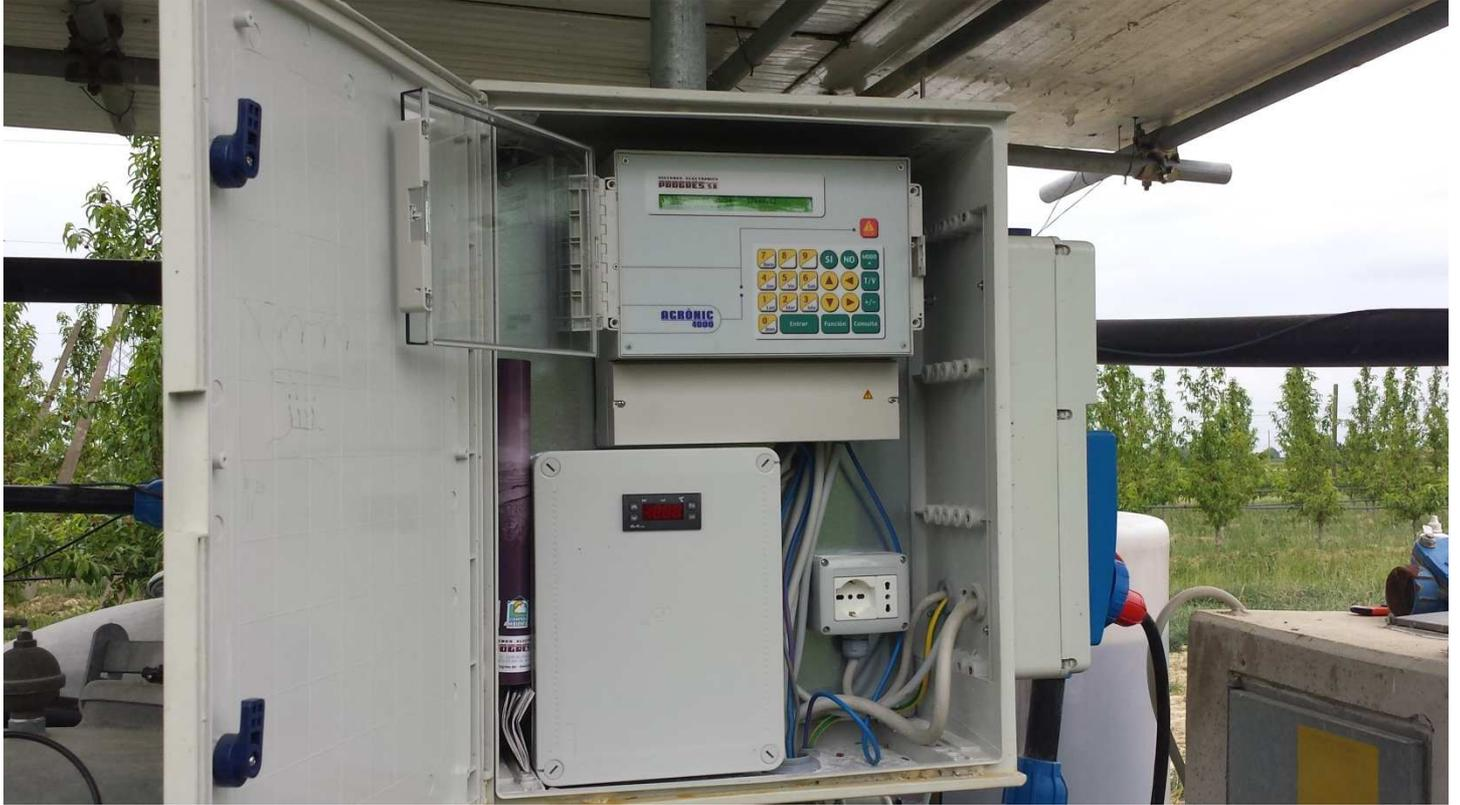
Impianto di fertirrigazione con Centralina Agronic 4000 per il controllo di 4 concimi e pompa acido.
