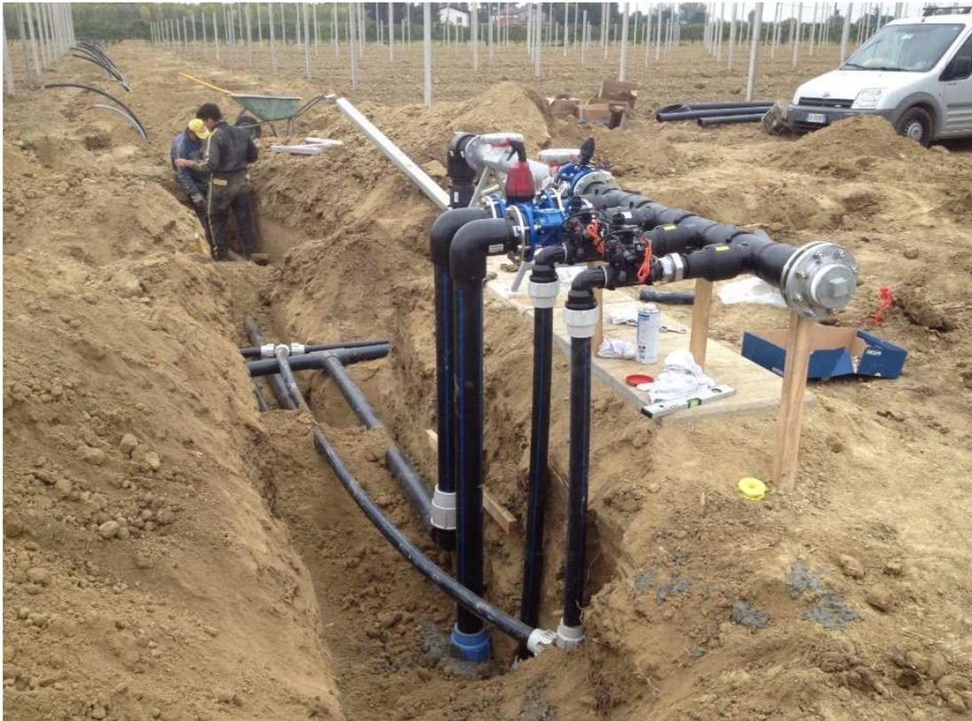
**Stacco valvole settore con ricevitore radio 12v
