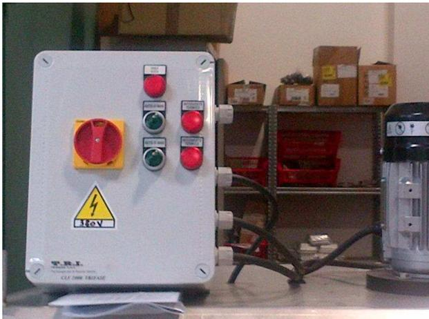
**Quadro elettrico elettromeccanico 0/Man/Aut per il controllo della pompa e agitatore
