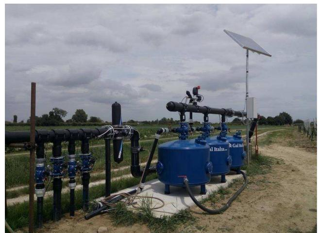
Centralina Agronic 4000 alim 220v per gestione irrigazione, ferrirrigazione e lavaggio filtri, il sistema via radio permette il comando valvole in campagna
