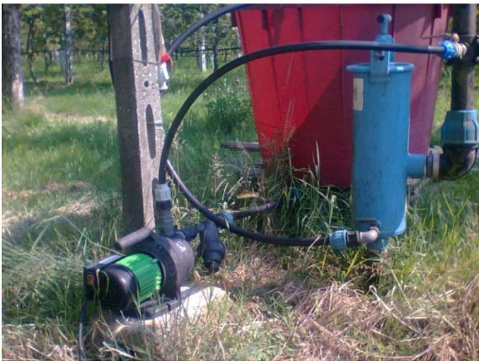
Centralina Agronic 4000 cablata con sistema radio e sonda temperatura per il controllo di di 2 impianti antibrina e goccia su kiwi con le rispettive stazioni di filtraggio
