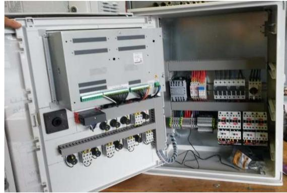
**Quadro elettrico con centralina Agronic 4000 cablata per il controllo di una pompa elettropompa
