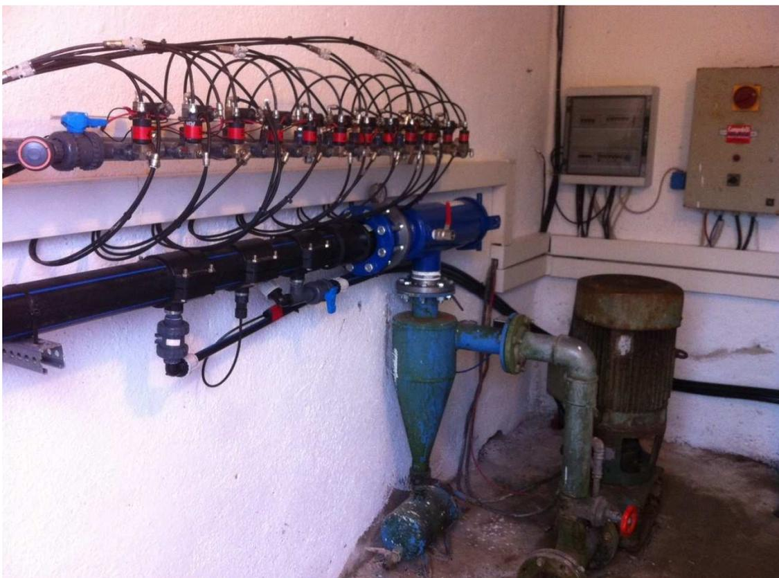
**Banco di fertirrigazione con pompa di rilancio, per controllo di 4 fertilizzanti più acido.
