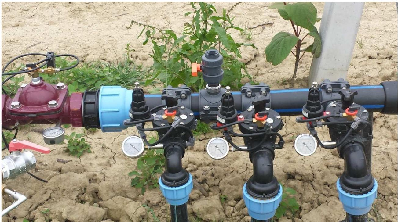
**Stacco idrovalvole in PP con solenoide 9v**
