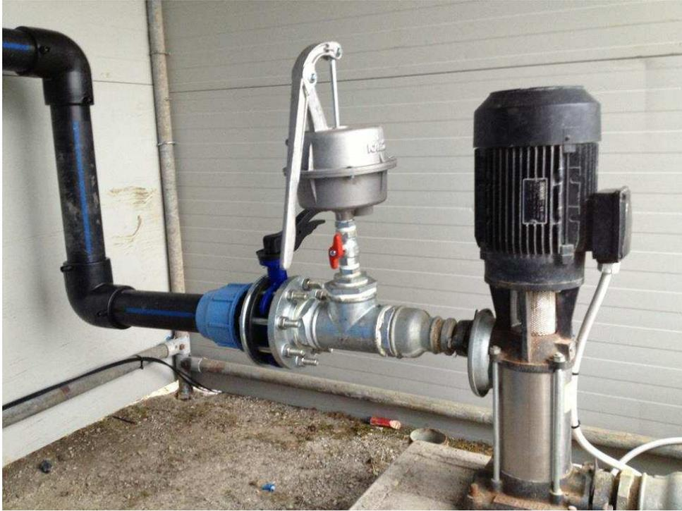
**Elettropompa Calpeda ad asse orizzontale, con pompa a membrana per facilitare il caricamento.**
