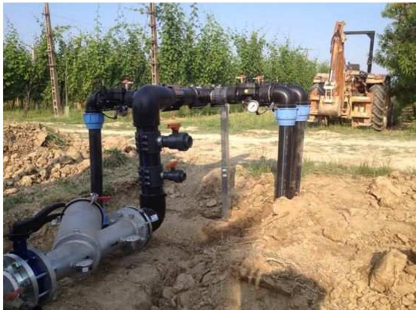
Filtro di sicurezza con stacco idrovalvole in ghisa co pilota riduzione pressione
