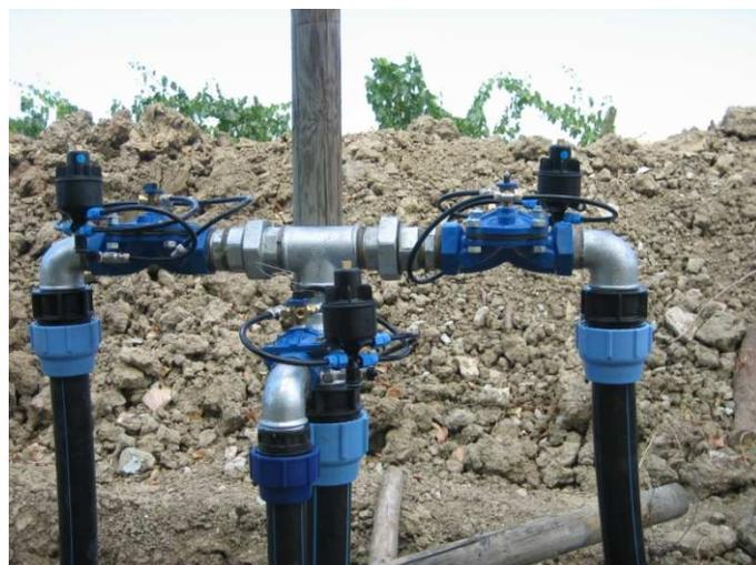
Idrovalvole settore con pilota riduzione pressione e solenoide 9V su campo di mais
