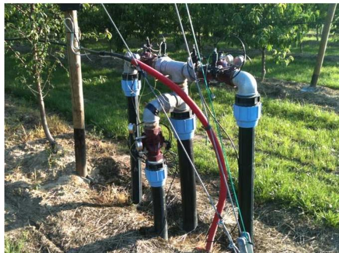
**Stacco valvole settore, con idrovalvole in ghisa manuali e pilota rid. pressione**
