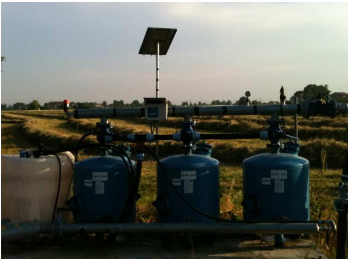
Batteria 4x750 Amiad alimentazione 12V continuo con pannello fotovoltaico.
