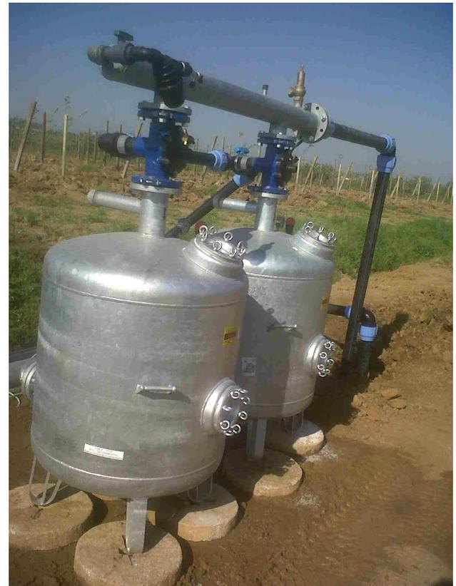
Batteria quarzite 2x950 Alimentazione 220V . Filtro di sicurezza a spazzola DN 125.
