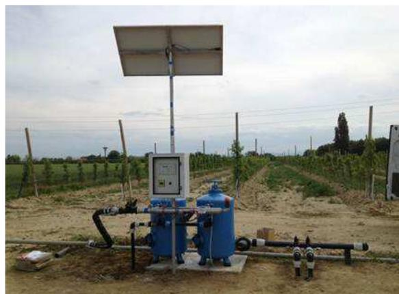
**Batteria quarzite 2x700 manuale con filtro sicurezza rete DN80 e idrovalvola riduzione pressione**
