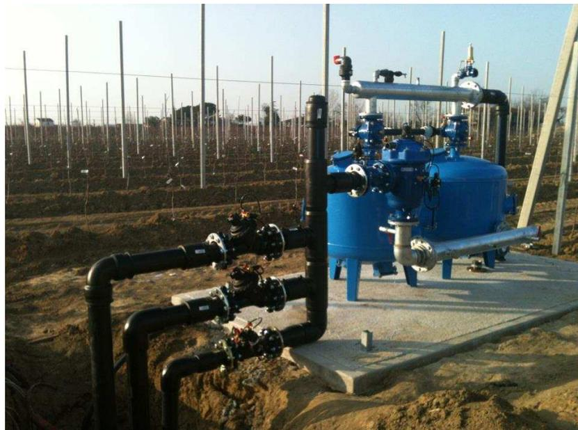
Batteria quarzite 3x750 STF alimentazione 12V continuo con pannello fotovoltaico con ricevitore per comando radio
