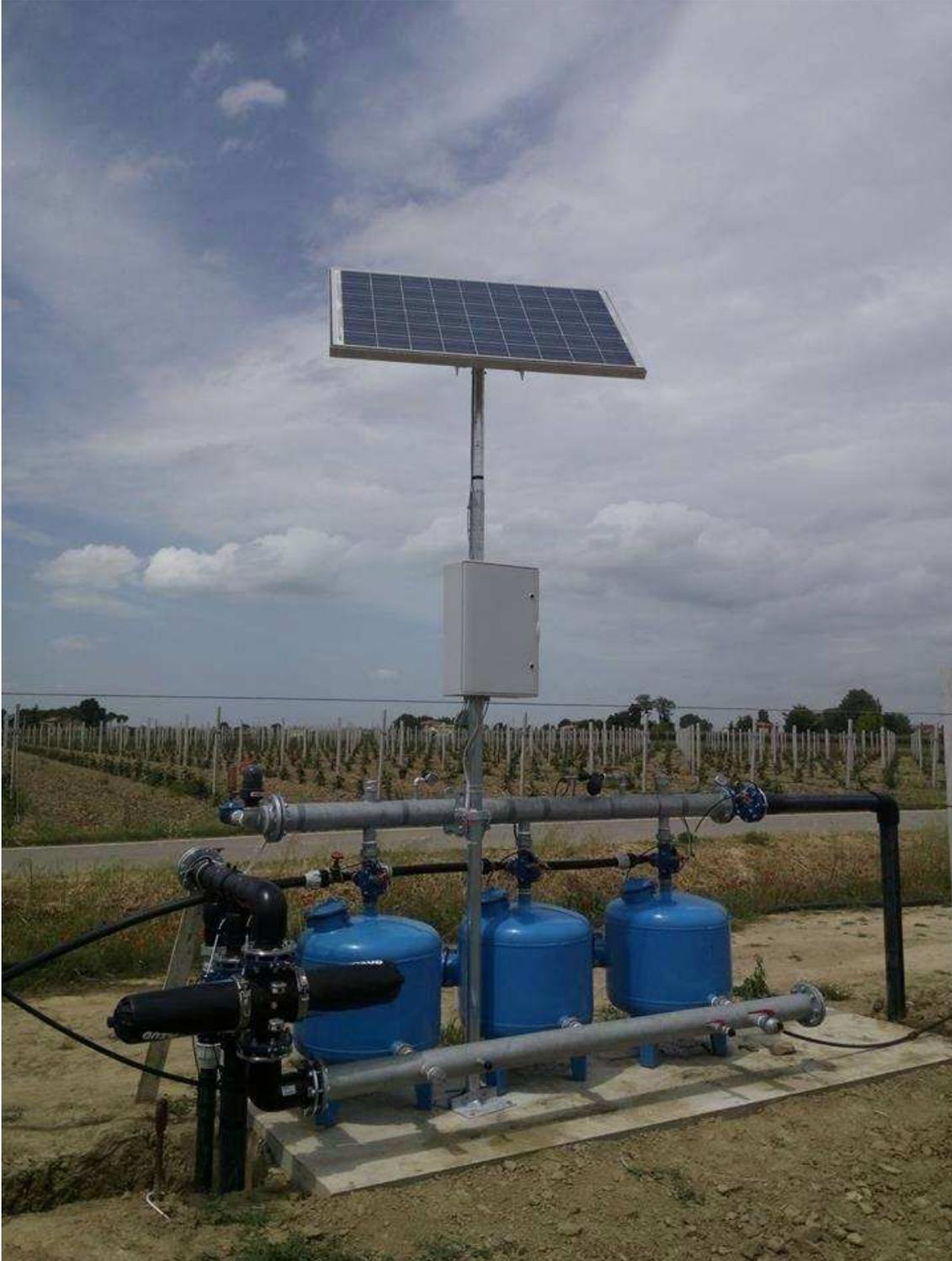
Dettagli batteria quarzite 3x750 STF , si nota la valvola master, l'idrovalvola scarico rapido, lo sfiato area doppio effetto , il collettore stacco valvole in PE elettrosaldato, e il filtro di sicurezza doppia cartuccia
