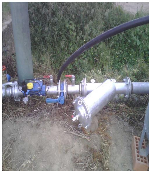
**Batteria quarzite 2x750 STF alimentazione 220V – con elettropompa asse verticale e pompa manuale a membrana per caricamento pompa. Collettore di stacco settori in PE elettrosaldato. Centralina Agronic 2500, per controllo dell'irrigazione lavaggio filtri.**
