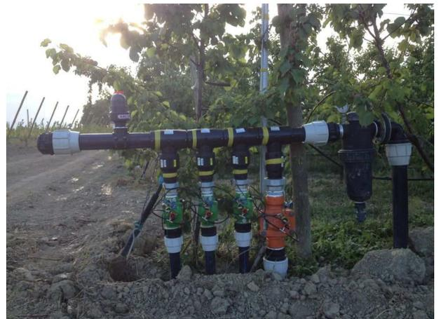
Batteria 3x900 zincata, alimentazione 220V. Centralina Agronic 4000 sistema via radio per comando valvole. Fertirrigazione con serbatoio da 1000 L con pompa e agitatore.
