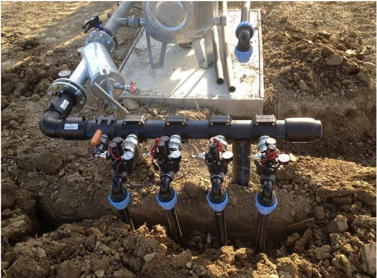
Batteria quarzite 2x600 Odis alimentazione 220V – con comandi idraulici alle valvole.
