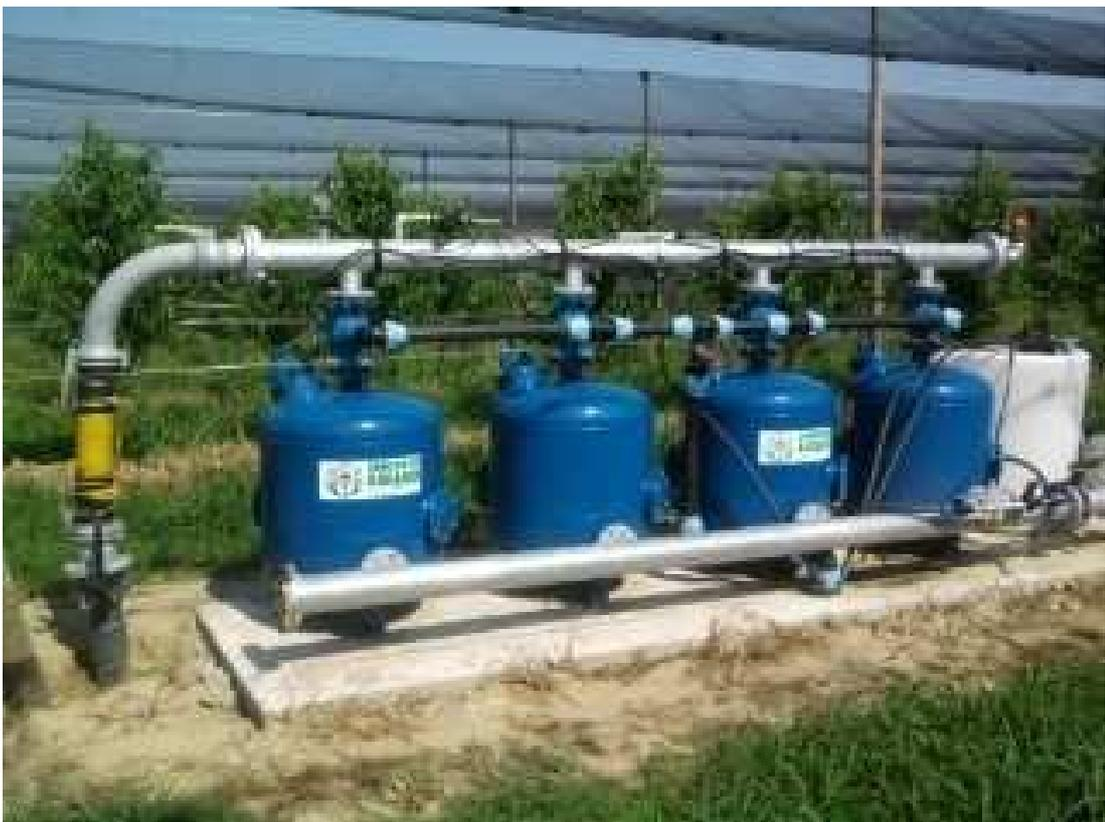
Batteria quarzite 3x750 Amiad su carrello alimentazione 380V con pompa asse verticale Caprari da 30 HP
