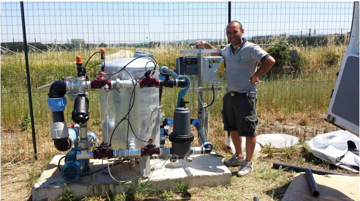
**Filtro monocamera con controlavaggio d.750 manuale – predisposto per automazione con centralina.**
