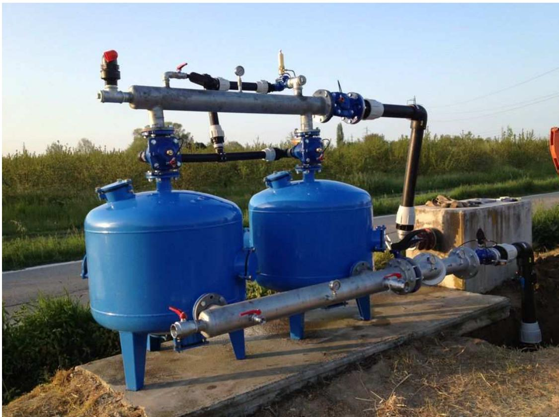
Batteria quarzite 2x950 Alimentazione 220V . Come filtro di sicurezza è presente un Filtomat 104C -DN100 Idrovalvola di scarico rapido sul collettore ingresso filtri.
