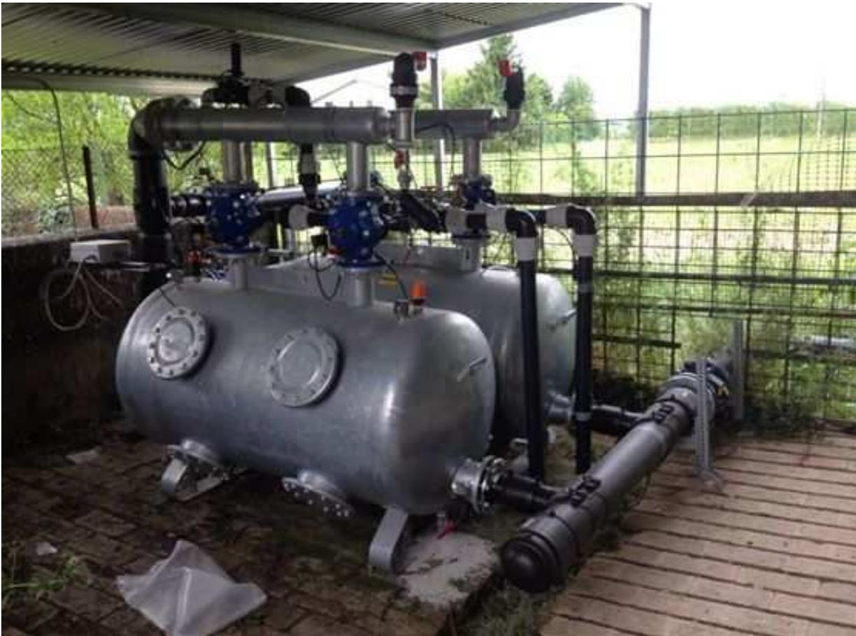
Filtro doppia camera d.800 autom. 12v con La centralina lavaggio filtri è alimentata da pannello fotovoltaico
