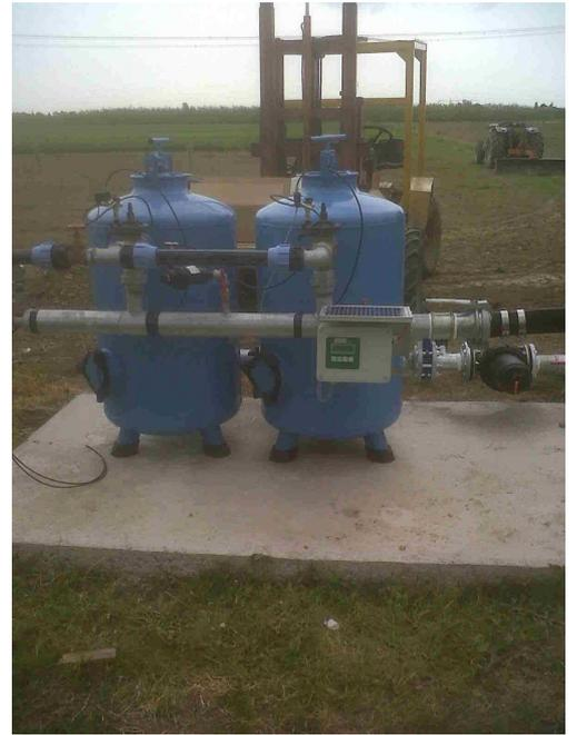
**Batteria quarzite 2x600 Odis alimentazione 12V – continua con pannello fotovoltaico. Centralina Agronic 2500 cablata su quadro, per controllo dell'irrigazione lavaggio filtri.**
