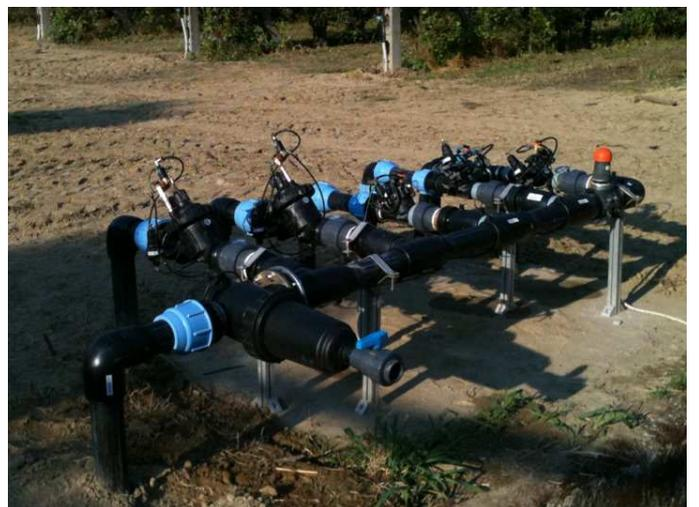
**Batteria filtraggio 6x750, alimentazione 220V. Come filtri di sicurezza sono presenti 2 filtomat 104C DN100. Centralina Agronic 2000 cablata su quadro per gestione irrigazione, lavaggio filtri e fertirrigazione.**
