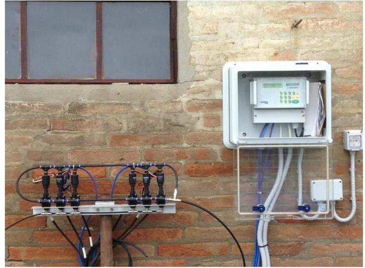
Batteria quarzite 2x600 Odis alimentazione 220V – con Kit di fertirrigazione automatico (pompa e agitatore).
