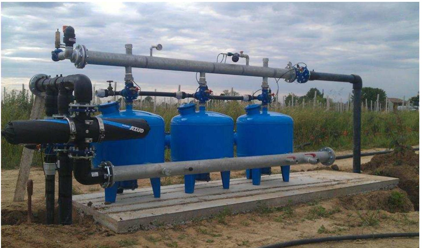
**Batteria quarzite 3x1050 Amiad alimentazione 12V continuo con pannello fotovoltaico con ricevitore per comando radio**
